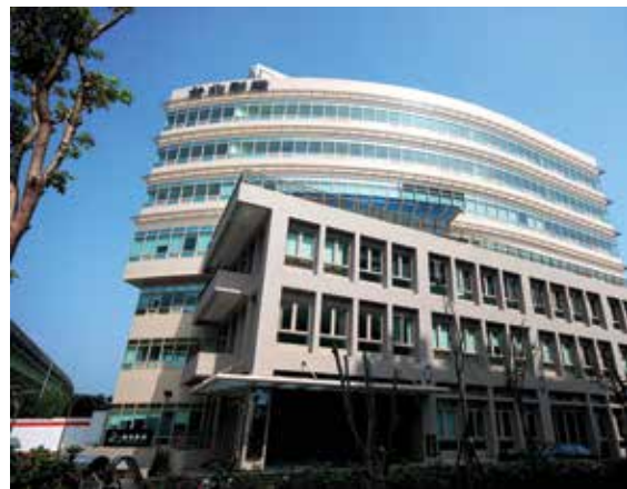
▲ 台北影业股份有限公司外貌
